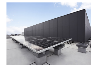
オークウッド京都御池の太陽光パネルの設置風景
